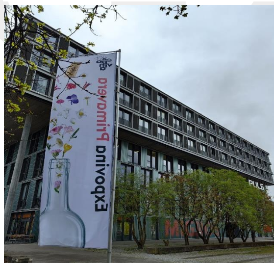
IMAGEN 1. PABELLÓN PULS, 5 ZÚRICH-WEST
